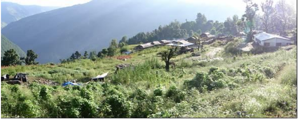
ग्राम नुराणू भूस्खलन से क्षतिग्रस्त व सक्रिय भूस्खलन के कारण terrifically vulnerable जूनियर हाईस्कूल व आवासीय मकान क्षेत्र ।
