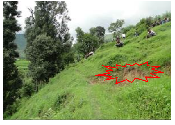
ग्राम टाण्डी toe erosion एवं मृदा का सन्तृप्त अवस्था के परिणामस्वरूप कारण अपहिल का 40^{\circ} - 45^{\circ} के ढलान वाला अस्थिर अवस्था की ओर अग्रसर भूभाग।
