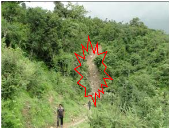
ग्राम टाण्डी के बौंगाड़ सदाबहार नालें में, आबादी क्षेत्र के निकट अपस्ट्रीम में भूस्खलन का क्राऊन एवं स्कार्प जिसके अपहिल में tensional cracks में विचलन स्खलित क्षेत्र की स्थिति।
